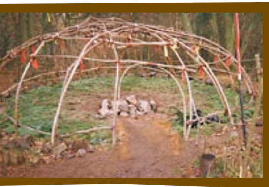
Die traditionelle Bauweise der Lakota-Schwitzhütte – 16 Weidenstangen und die Steine im Zentrum
